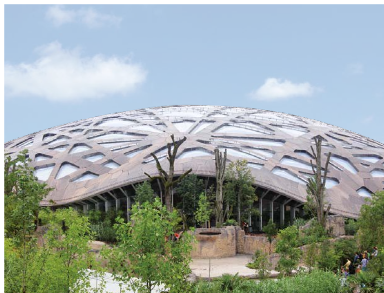
esb im Objektbau: Elefantenhaus in Zürich
