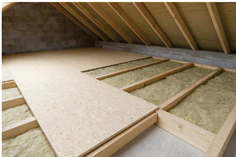
esb-Platten sind durch ihre günstigere Diffusionsoffenheit die bessere Wahl als Deckenplatte im Dachstuhl.
